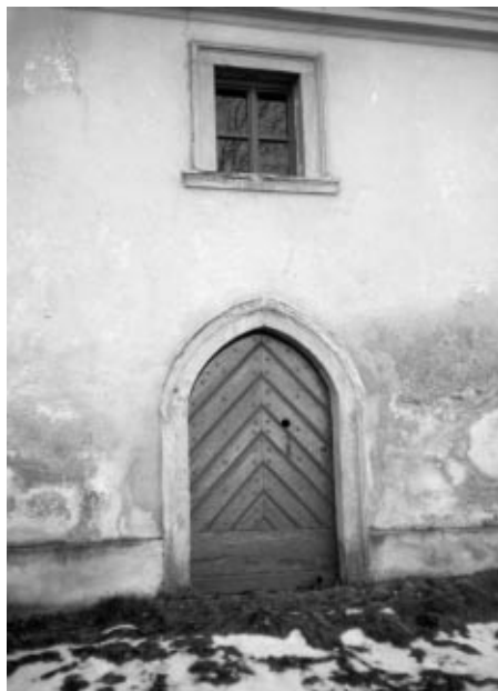
Seč. Kostel sv. Vavřince, severní fronta. Gotický portálek sakristie patrně z původního kostela. Dnešní stav. Snímek Jaroslav Teplý.
