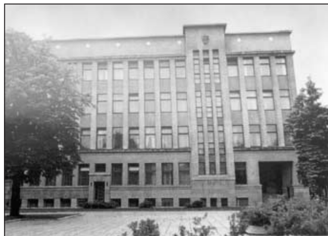
hlavní budova KTU
