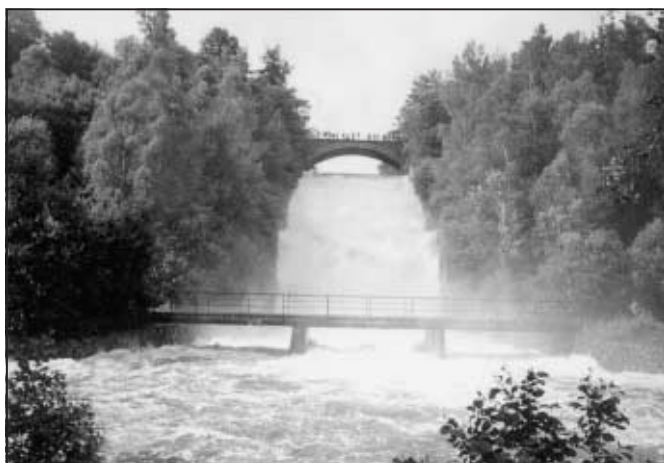
Přehrada Seč. Za vysokého vodního stavu (snímek z 8. července 1997) jde voda přes schodovitý přepad do koryta Chrudimky. Hrad Vildštejn je vlevo od horního mostu. Prodejná pohlednice.
